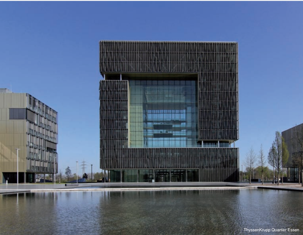
ThyssenKrupp Quartier Essen
